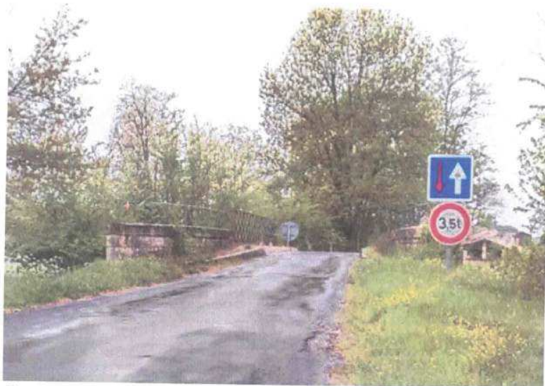
Pont surplombant la voie ferrée des TER (Photo CE)
